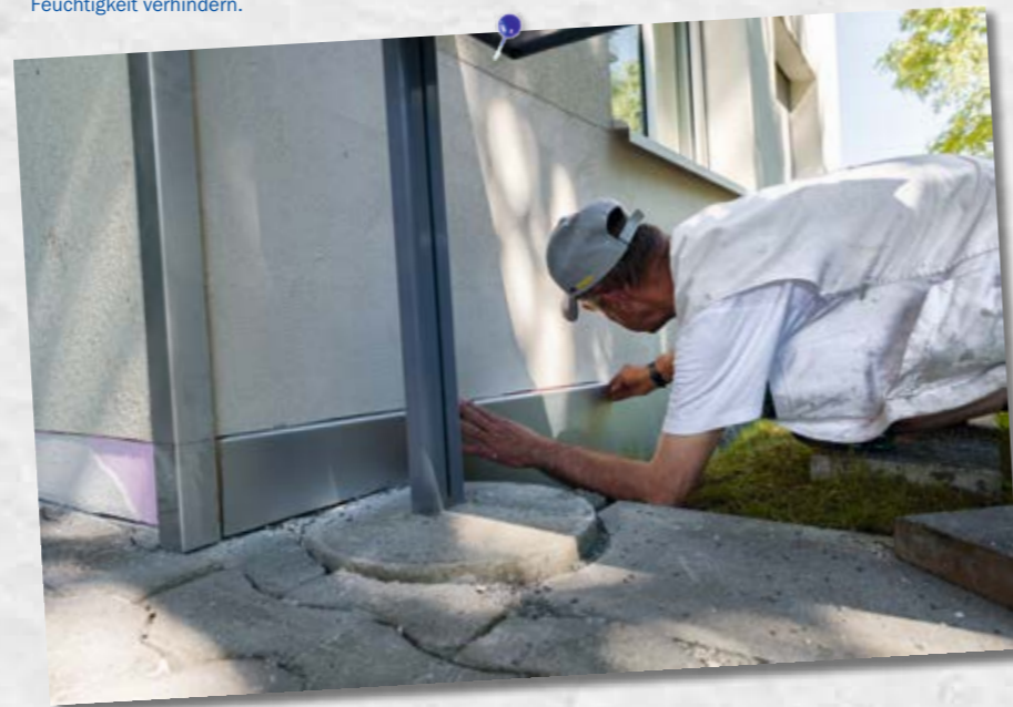
Präzision. Durch einen sauberen Kapillarschnitt und das montierte Sockelblech wird das Aufsteigen von Feuchtigkeit verhindert.
