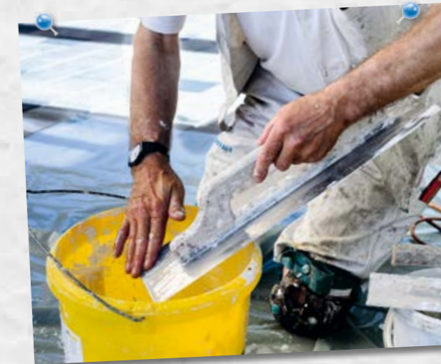
Handwerk. Damit eine glatte Fläche entsteht, braucht es Fingerspitzengefühl und Erfahrung. Und sauberes Werkzeug, das nach jedem Auftrag gereinigt wird.
