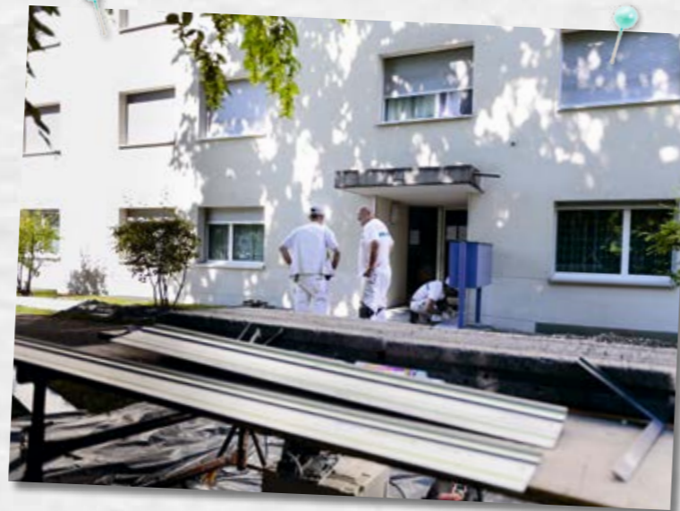
Präzision. Durch einen sauberen Kapillarschnitt und das montierte Sockelblech wird das Aufsteigen von Feuchtigkeit verhindert.
